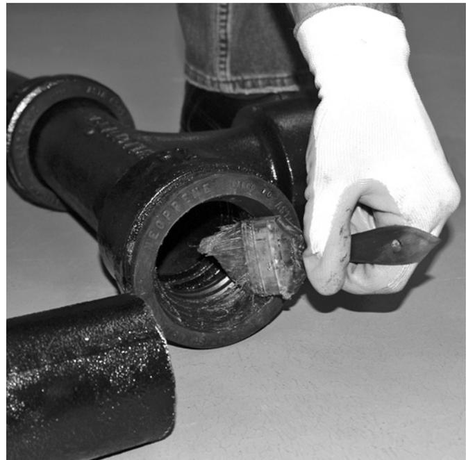
Para las tuberías y conexiones de diámetro mayor (de 5 a 15", de 125 a 375 mm), le recomendamos que utilice un lubricante adhesivo para asegurar un sello hermético. Los adhesivos lubricantes se deberán aplicar en la parte interior del empaque, en la exterior de la espiga y en la interior de la campana.
