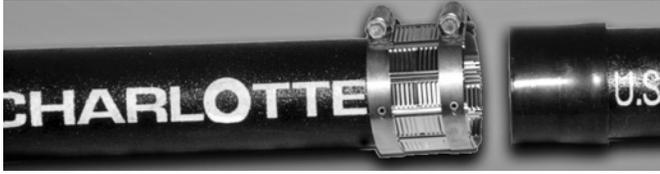
2. Inserte el empaque sobre la tubería o conexión hasta que el extremo final de la tubería o conexión tope en el hombro íntegramente moldeado en el empaque. Deslice el ensamble del cople sobre el otro tubo o conexión a unir.
