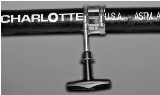
4. Deslice el ensamble del cople a su posición centrada sobre el empaque. En este punto, se recomienda el apriete a mano de todas las abrazaderas del ensamble del cople con una llave.
